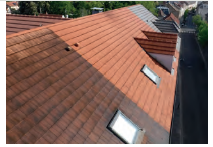
Démoussage (avec nacelle)
