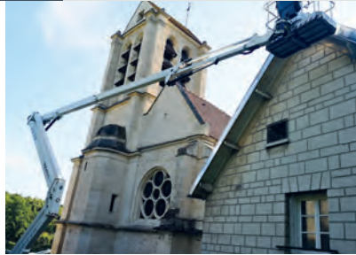
Réfection rives et gouttières
