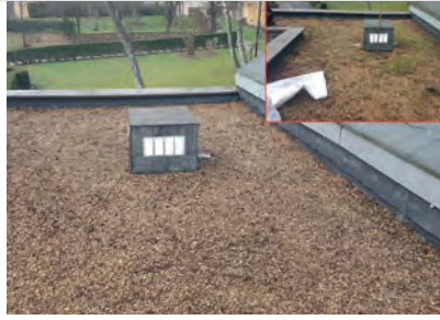
Toit terrasse gravillonné
