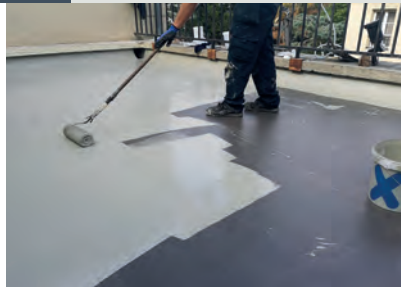
Étanchéité résine SEL
